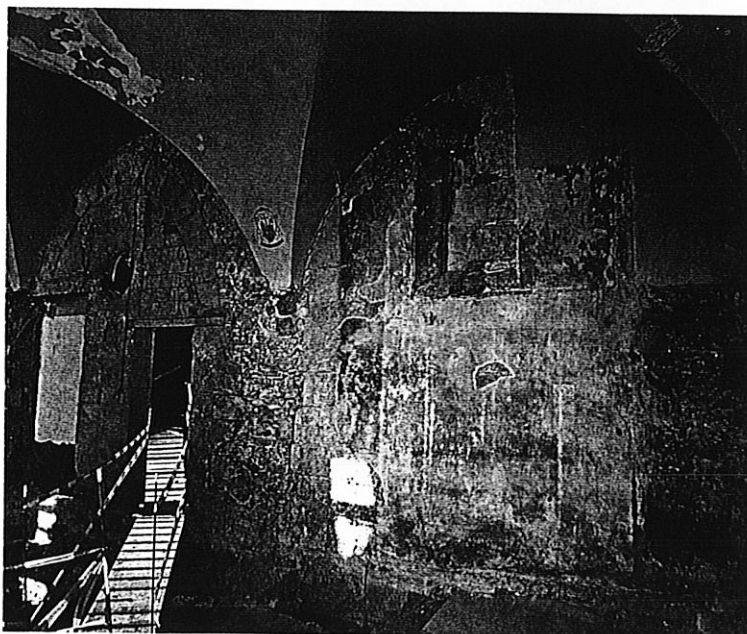
L'ancienne fenêtre de la chapelle Saint-André (à dr.) a conservé son encadrement peint gris foncé d'origine ; dans son bouchon de maçonnerie – correspondant à une transformation du XVII e siècle – des fragments de vitraux du XV e siècle bien conservés ont été retrouvés.
